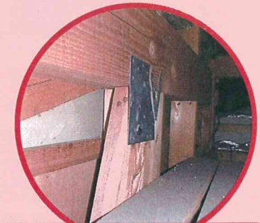
天井裏金物設置状況
