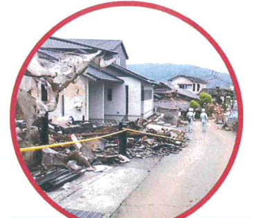
住宅の被災状況
