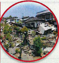
住宅の被災状況
