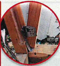
柱脚筋かい金物
